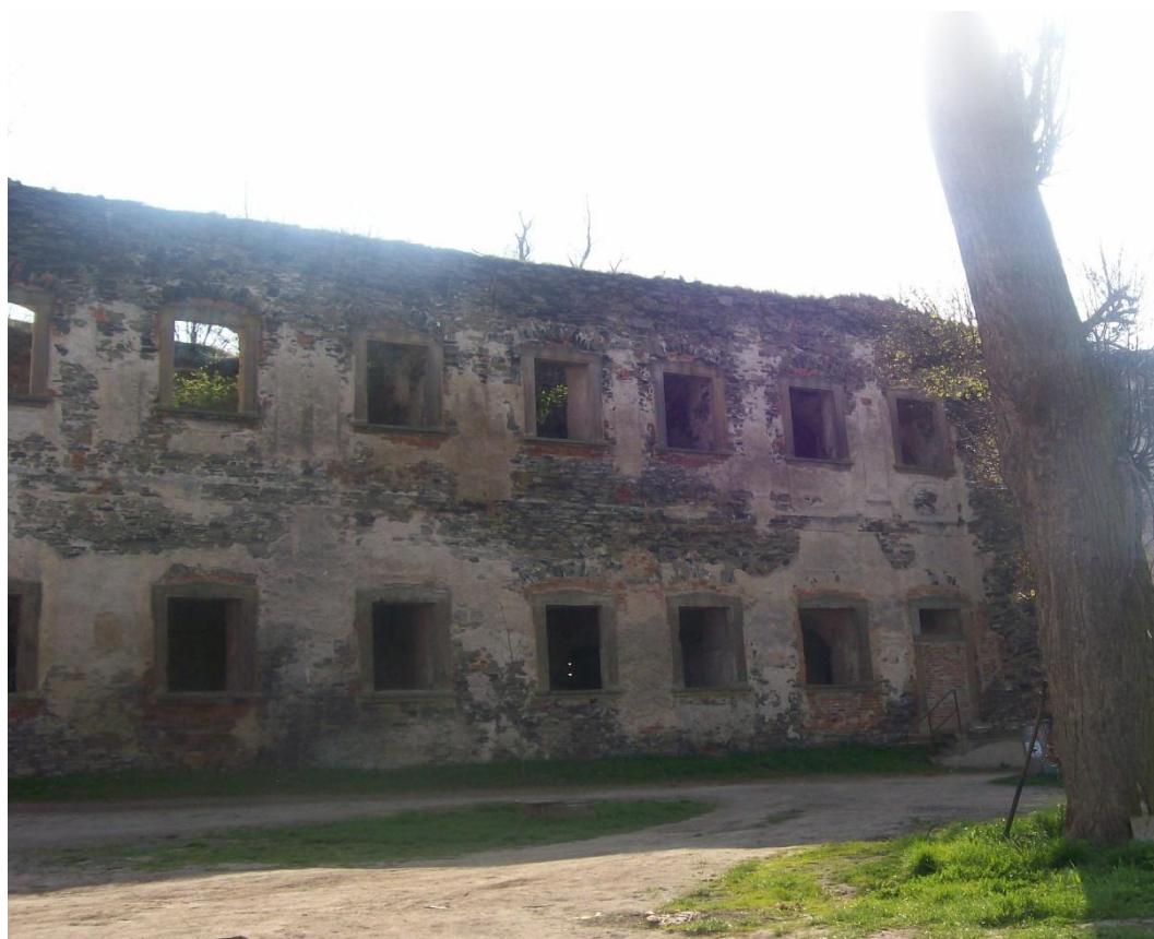
Zdjęcie 26. Grangia w Winnicy (obiekt pocysterski w ruinie). Rok budowy XVII w., przebudowa w XVIII w. i w 1810 roku. Dawny dom zakonników grangii cysterskiej.
