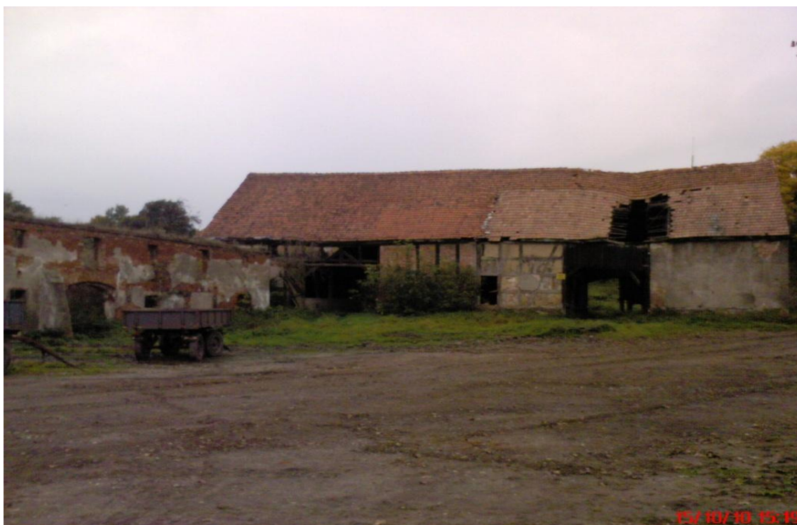
Zdjęcie nr 10. Wilczyce – niszcząca zabudowa budynków gospodarczych.
