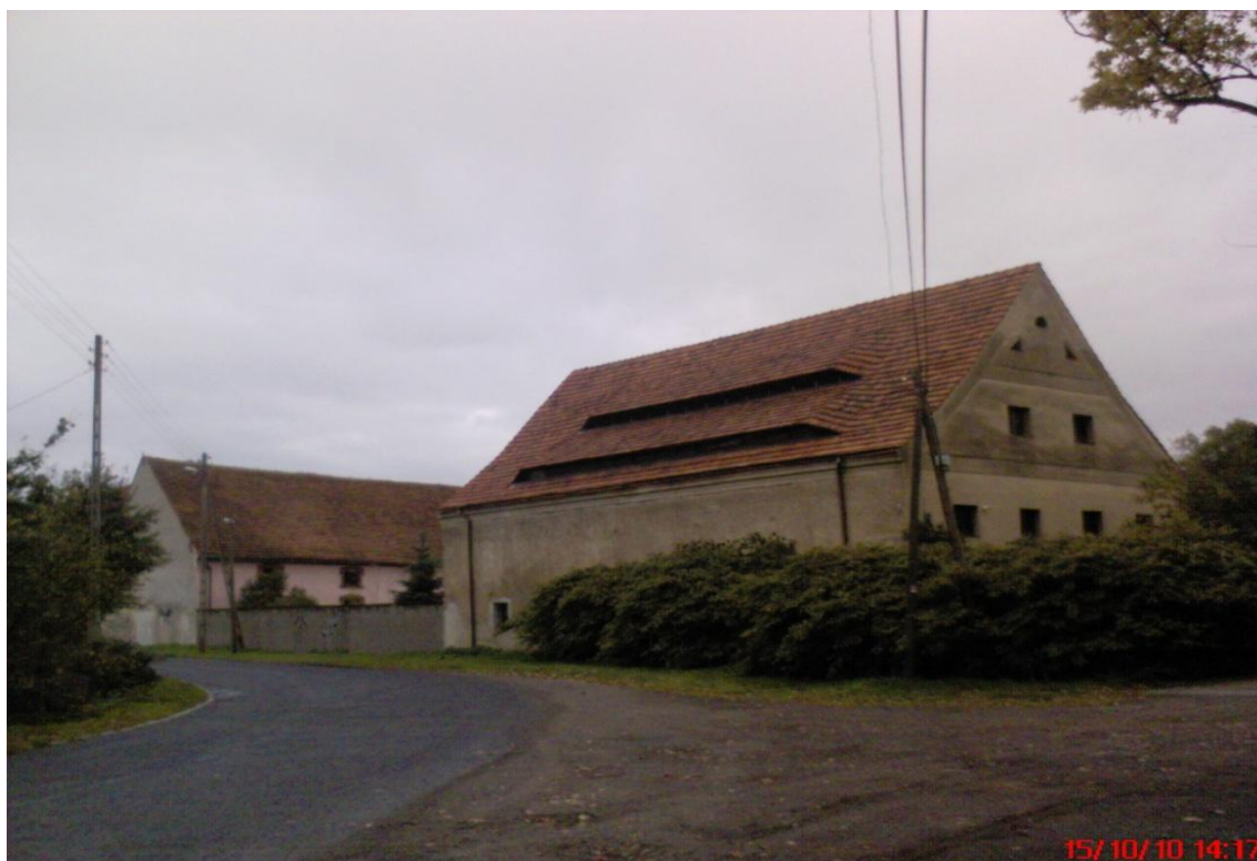
Zdjęcie nr 13. Warmątowice – budynek gospodarczy przy pałacu.
