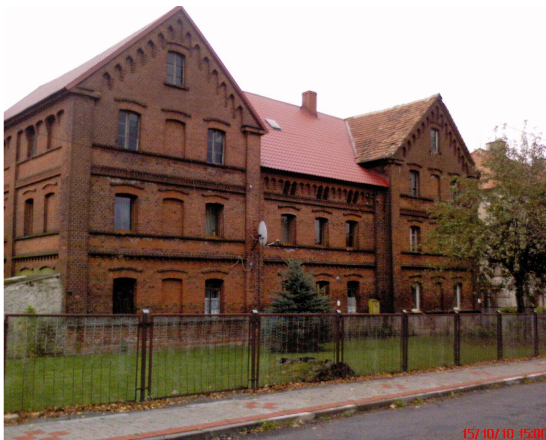
Zdjęcie nr 4. Krotoszyce – budynek mieszkalny z początku XXw. przy folwarku i pałacu.
