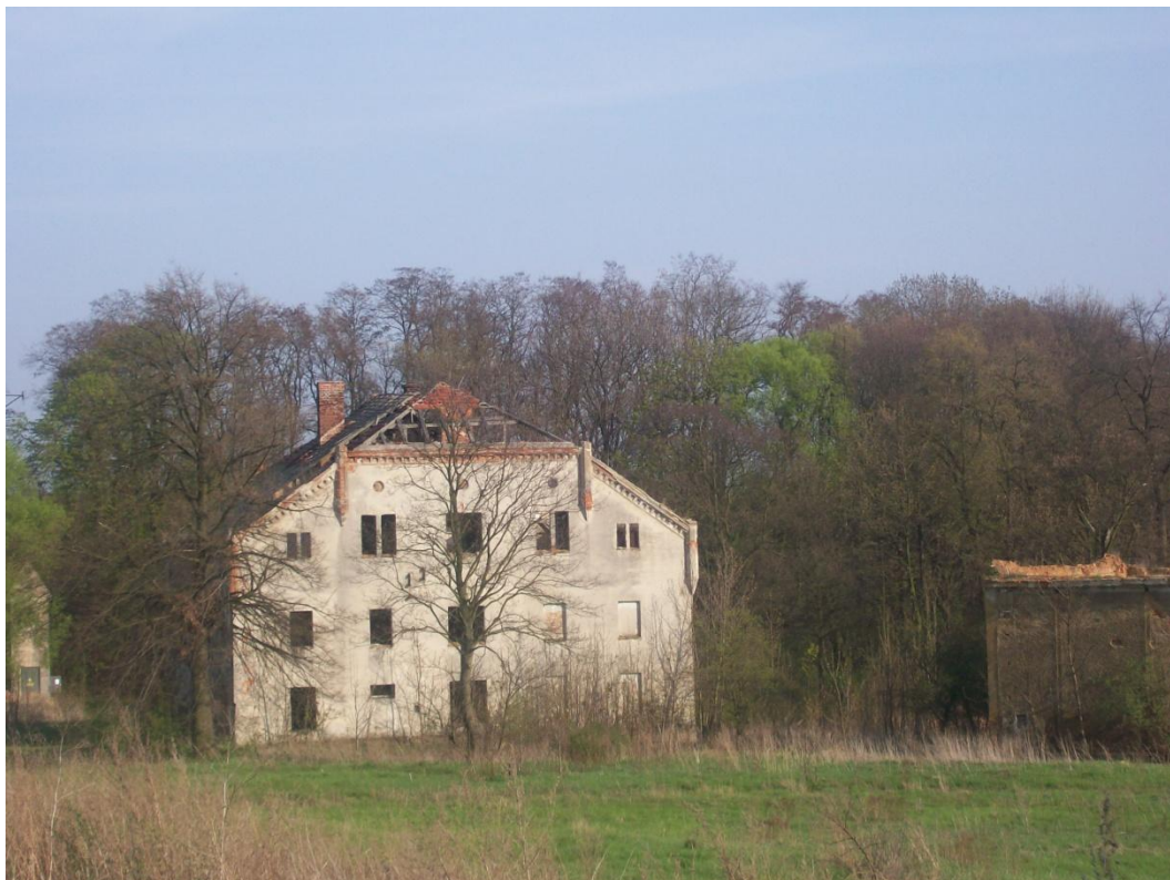
Zdjęcie 43. Pałac w Bielowicach (niszczący pałac i zabudowania folwarczne). Wieś związana z zakonem cystersów w Lubiążu. Dwór, park i zabudowania gospodarcze pochodzą z III ćw. XIX w.
